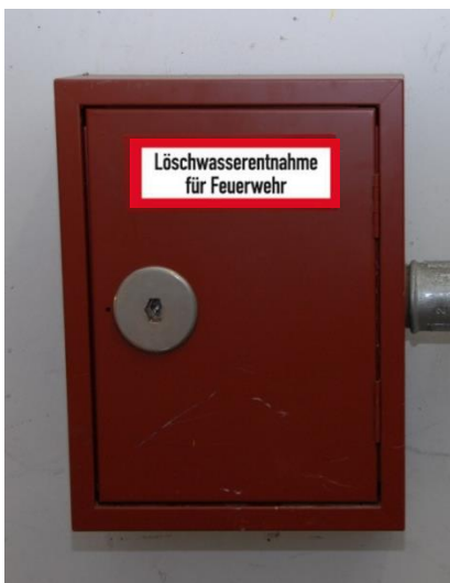
Abb. 11 Entnahmeeinrichtung
